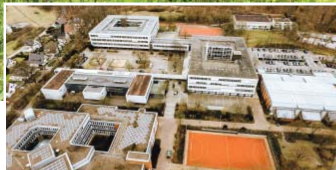
Luftbild vom Schulzentrum: Oben links ist die Gesamtschule Rosenhöhe, daneben das Berufskolleg Senne (Mitte). Hinter dessen Gebäude wird der Neubau der Oberstufe gebaut, die alte Turnhalle (oben rechts) soll abgerissen und ersetzt werden.
